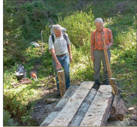
Brückenerweiterung am Moosensteig
